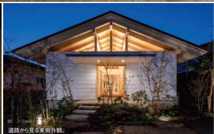
道路から見る東側外観。
