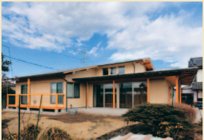
外観／軒が深く、立体感があるため、個性的な印象を受ける
